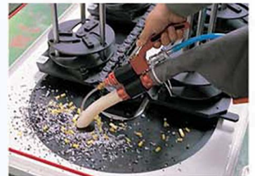
Eliminación de restos de cables en cadena de montaje
