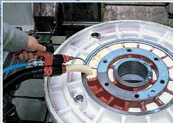
Succión de aguas residuales
